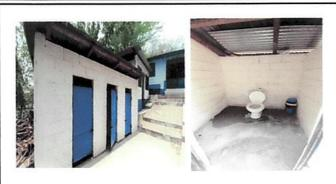
Foto1: Remodelación de baños, cambio de estructura metalica y lámina, pintura de baños.
